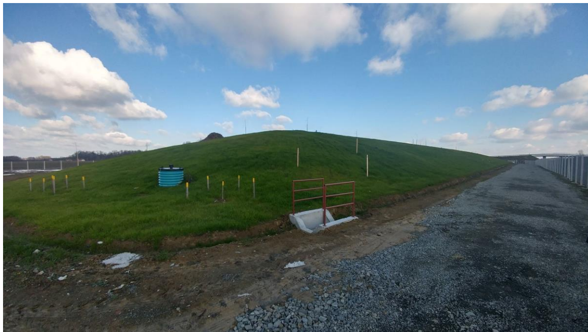
Slika 4. Sanirano odlagalište „Alabarica“
